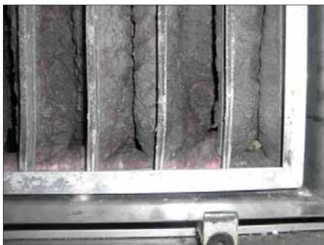
Detaljfoto fra et filter etter seks måneders bruk.
